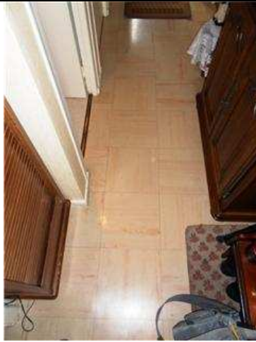
001 - Appartements - Entrée LOT 0102 PH30 : dalles supérieures non amiantées
