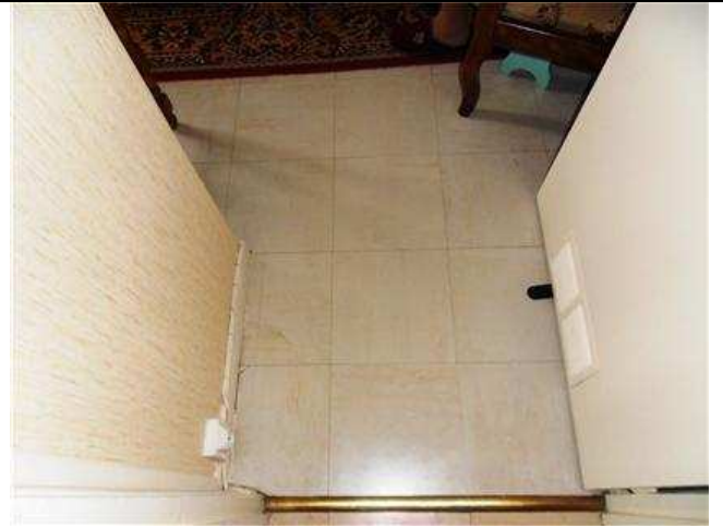
002 - Appartements - Séjour LOT 0102 PH31 : dalles supérieures non amiantées
